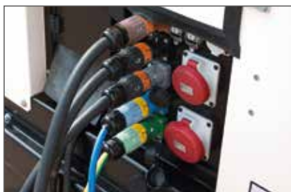
▲ Conectores de potencia
