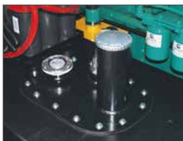
▲ Lector de nivel de combustible mecánico colocado junto al punto de llenado
