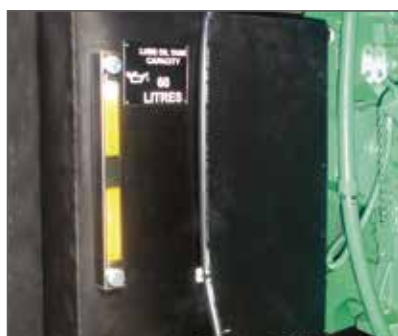
▲ Tanque y válvula reguladora de aceite
