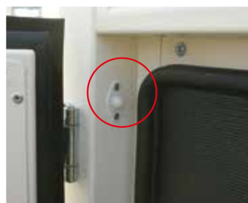
▲ Alarma para apertura de puerta (monitoreada remotamente)
