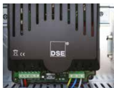
▲ Cargador de batería
